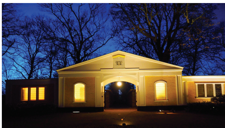
Impressie van de verlichting van het poortgebouw.
